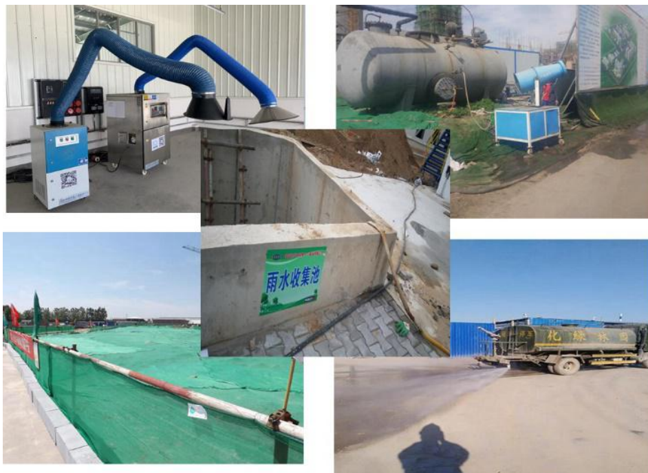
施工现场采取的各种环保措施
